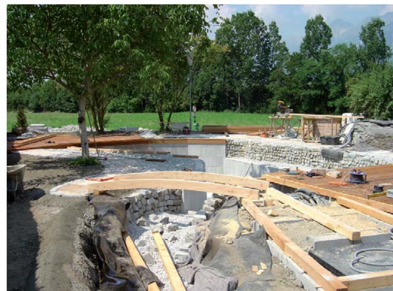
Der Schwimmbereich ist bereits gefliest. Die Holzelemente werden montiert.
