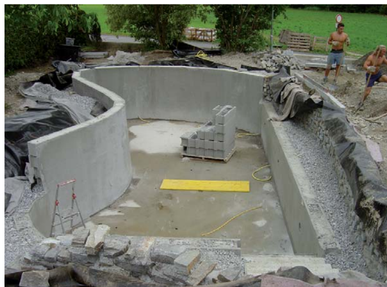
Aufbau des RABAGS® Pools: die Schwimmzone ist aufgebaut, die Filterzonen geschüttet.
