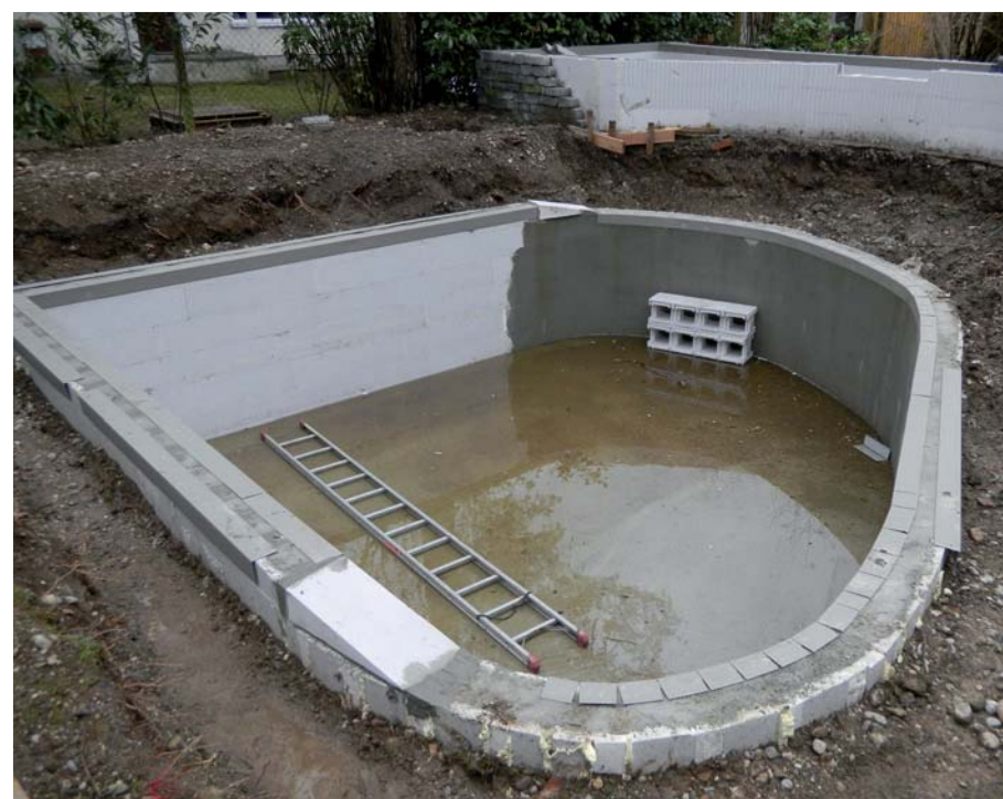
Aufbau der Schwimmzone und der erhöhten Regenerationszone mit ESP-Steinen
