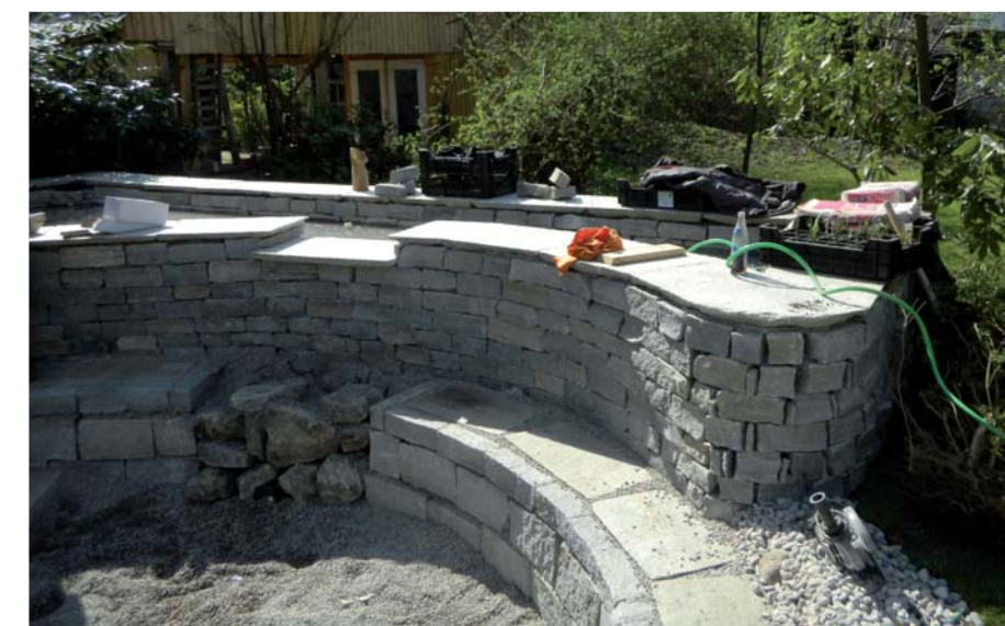
Fertiges Klärbecken mit Abdeckplatten
