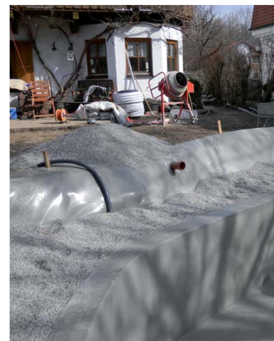
Abgedichtete Becken mit Blick auf den Notüberlauf
