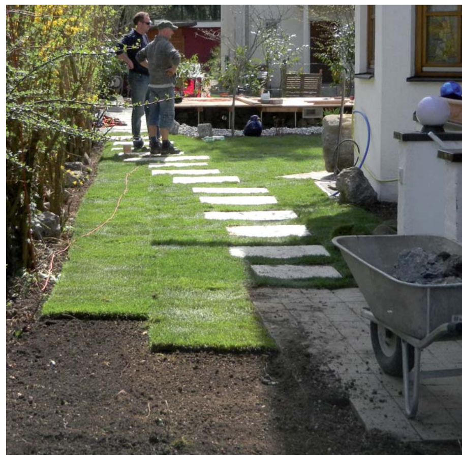
Verlegung des Fertiggrasens und der Trittplatten aus Gneis
