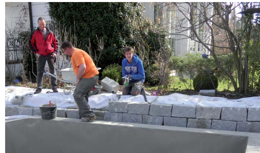
Aufbau der Uferböschung mit Wegeverlauf
